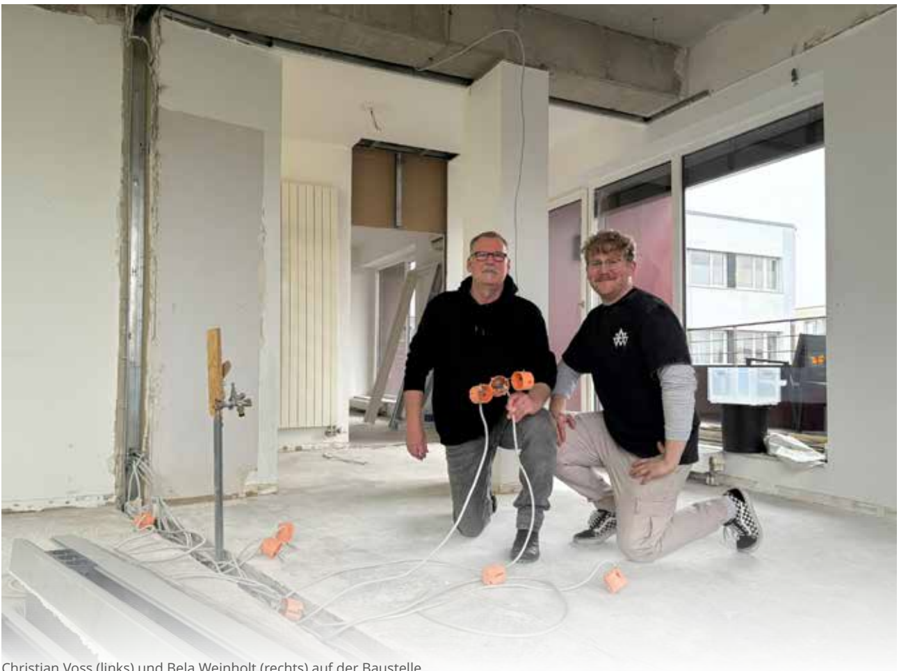
Christian Voss (links) und Bela Weinholt (rechts) auf der Baustelle.
